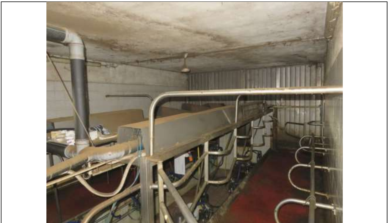
96 Vista della sala mungitura;
