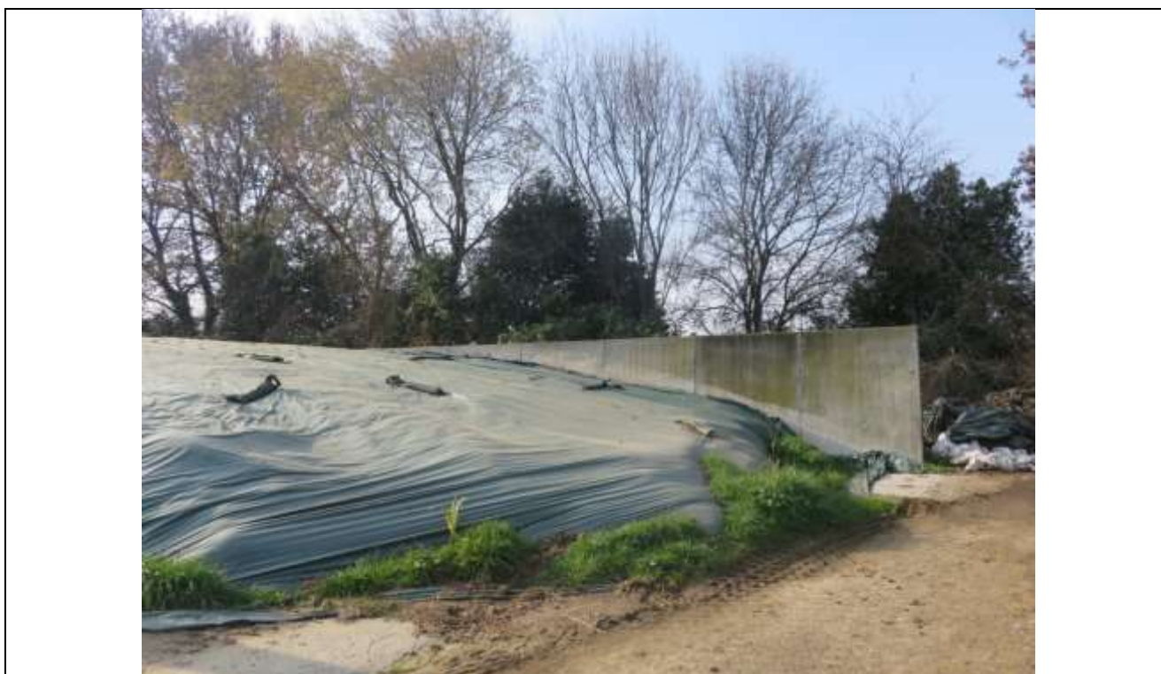
80 Altra vista della concimaia oggetto di demolizione;
