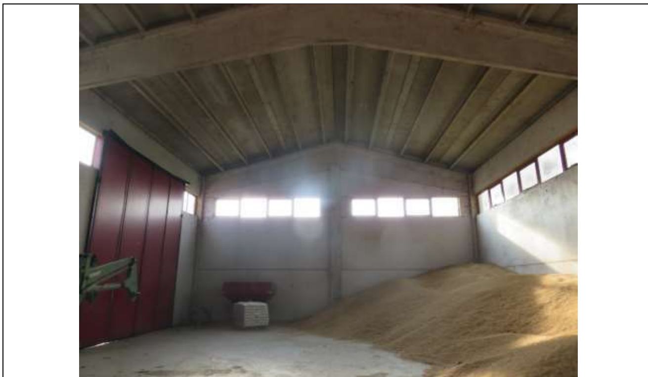
54 Vista interna dell'immobile 4;
