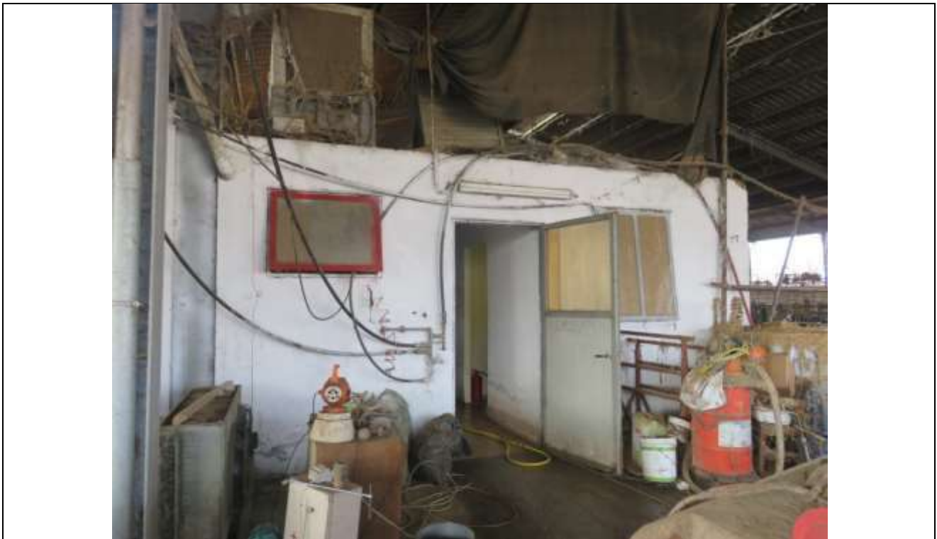
89 Vista dell'ingresso agli uffici;
