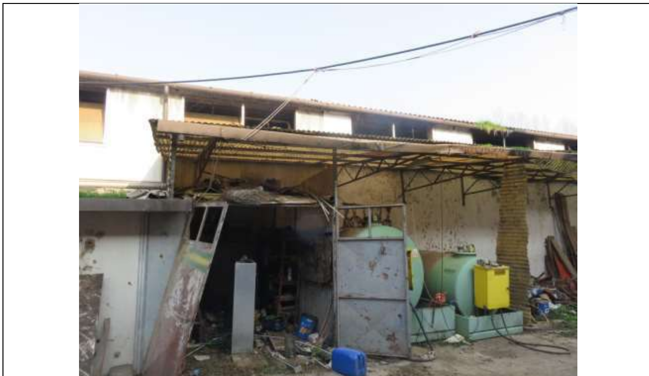
65 Altra vista delle baracche oggetto di rimozione;
