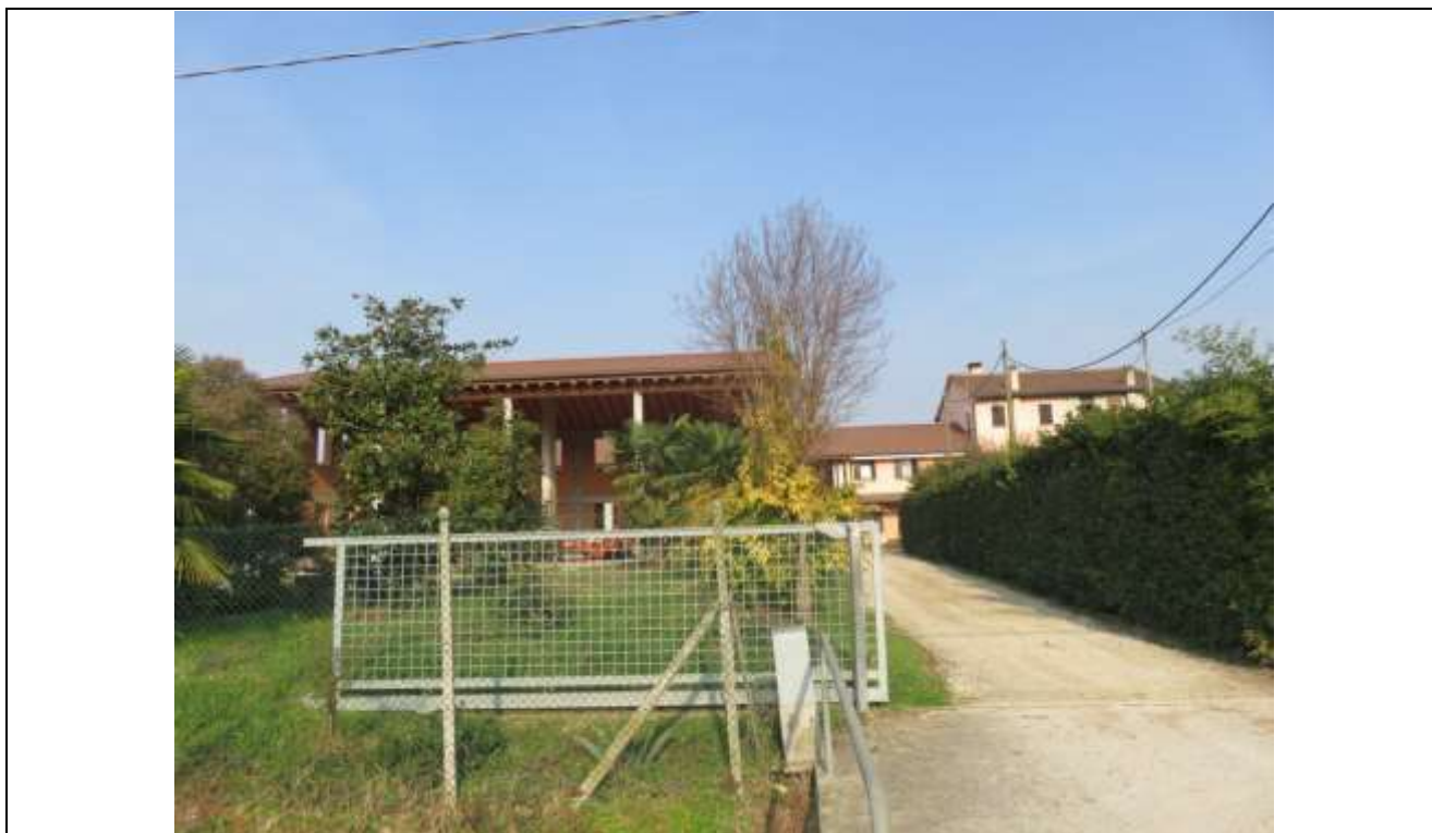
06 Vista dell'accesso carraio ad apertura automatizzata;
