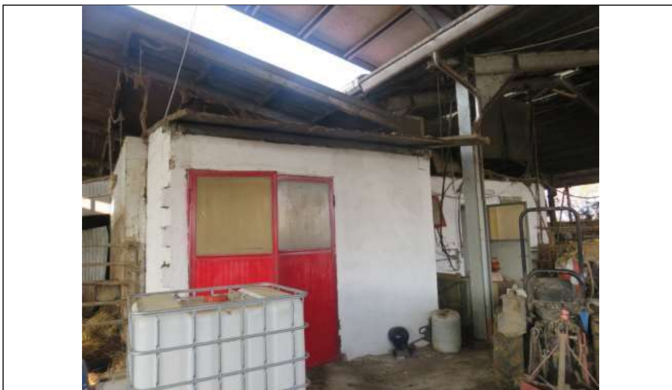
88 Vista dell'ingresso alla sala macchine;
