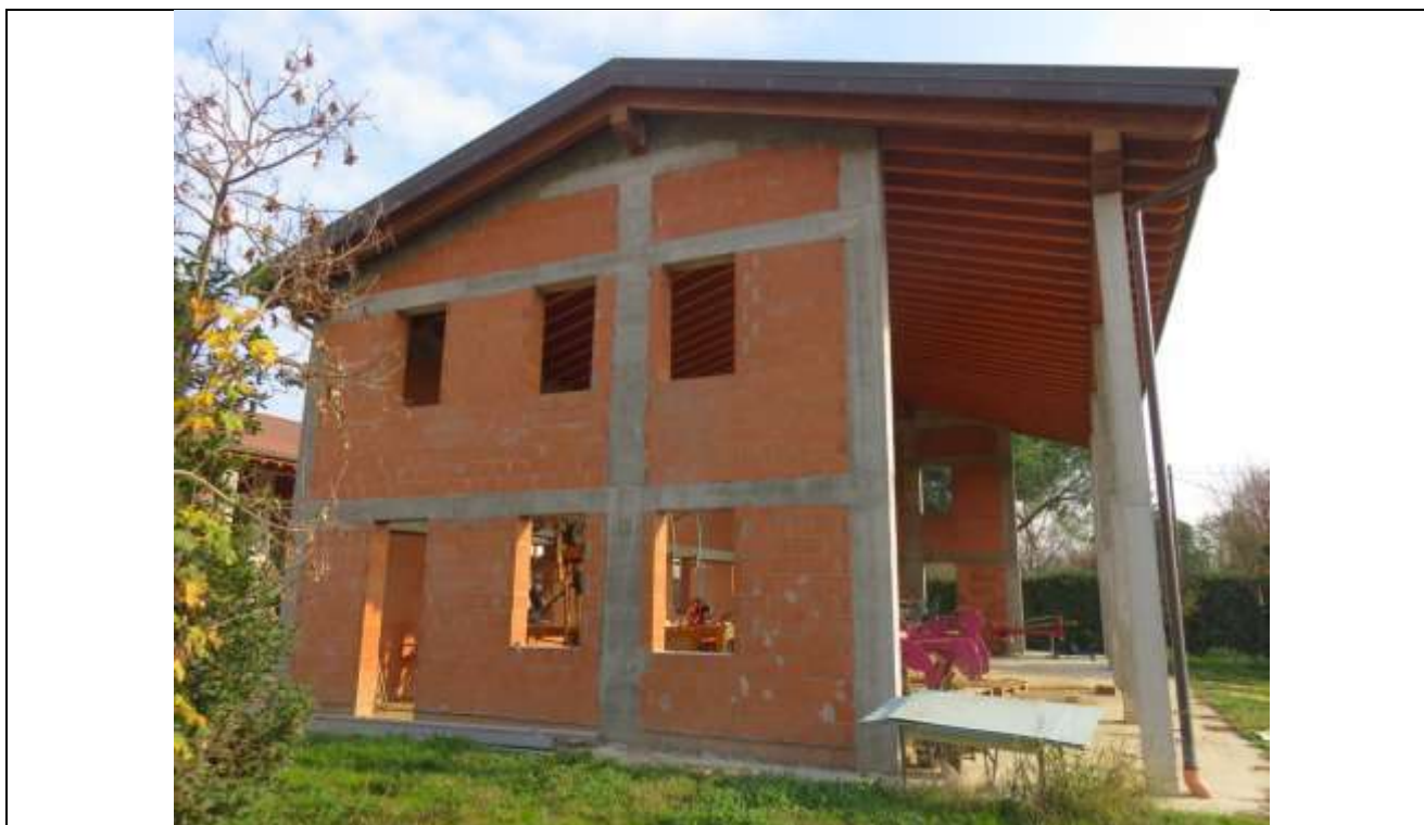
51 Vista del fronte Ovest dell'immobile 3;
