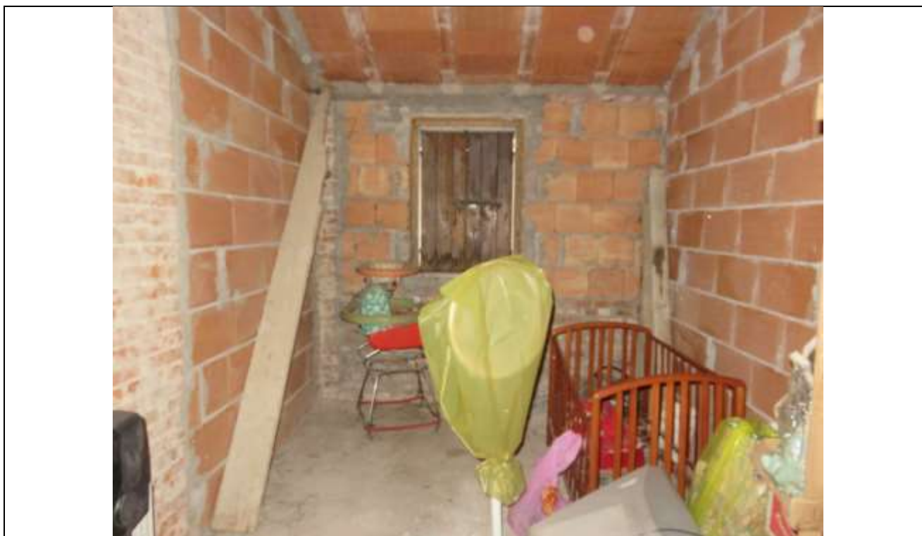
31 Vista della camera allo stato grezzo;
