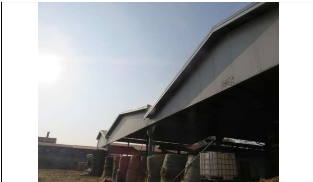
101 Altra vista dell'immobile 6 lato Est;
