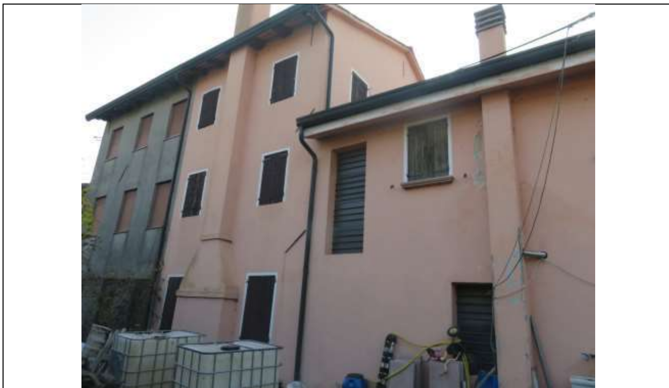
66 Vista del fronte Nord dell'immobile 1 -abitazione;
