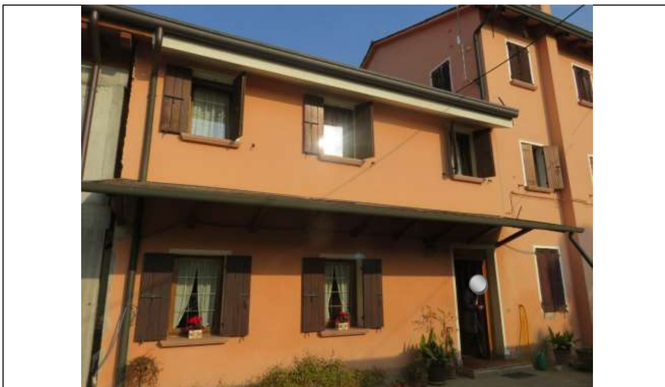
12 Vista del fronte sud dell'immobile residenziale;
