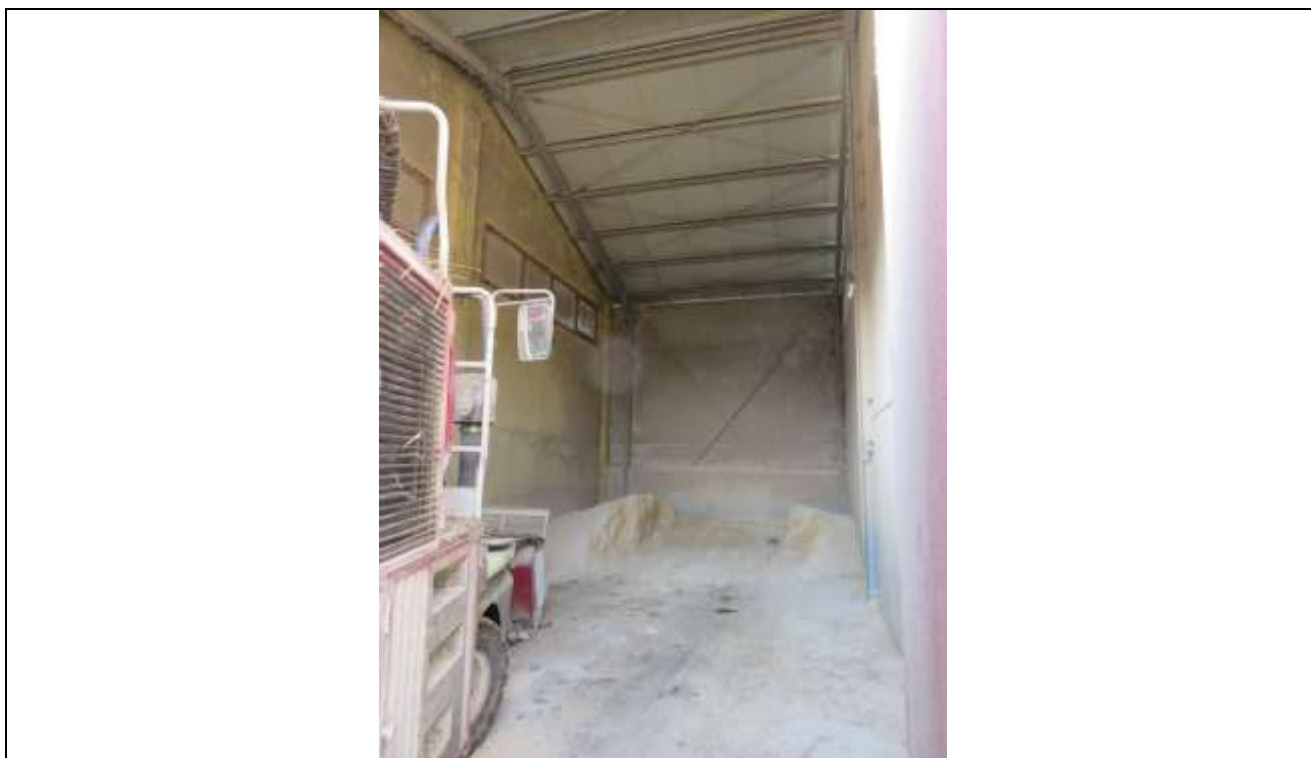
57 Vista interna della porzione in ampliamento;
