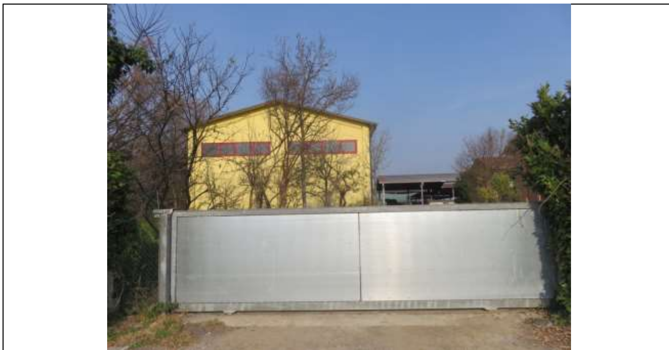
02 Vista del primo accesso carraio;
