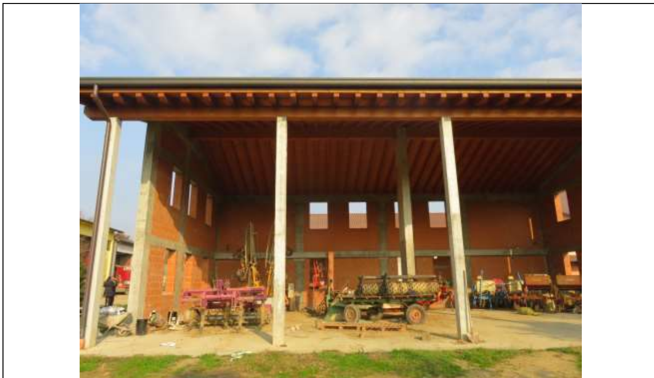
49 Vista del fronte Sud dell'immobile 3;
